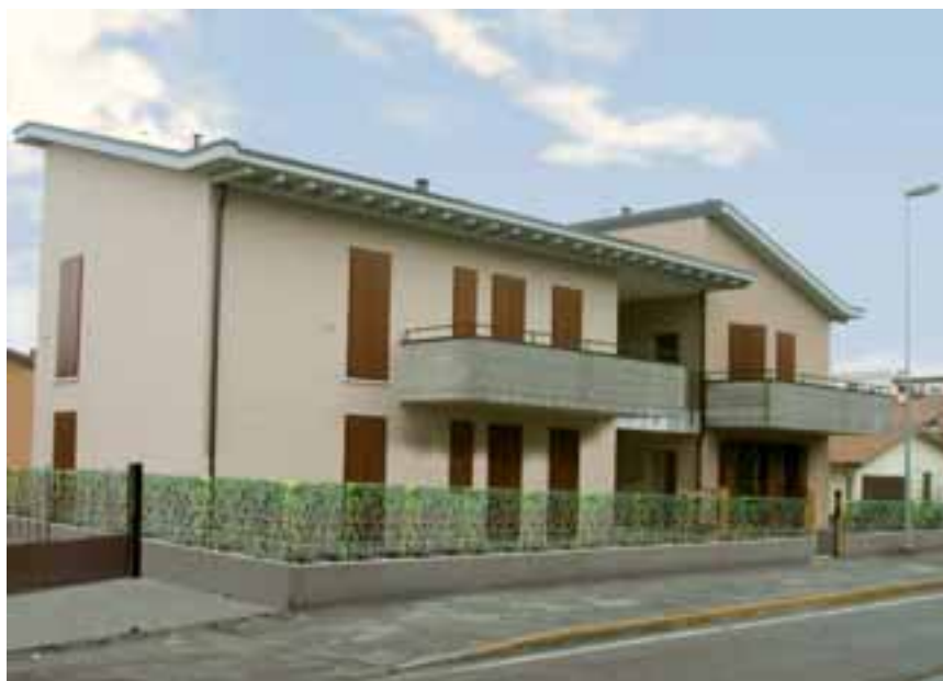
Edificio condominiale in fase di ultimazione a Calcinatello (Via Cavour - 4° lotto)
